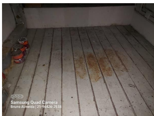
Figura 14 – Vista do piso metálico do mezanino existente
