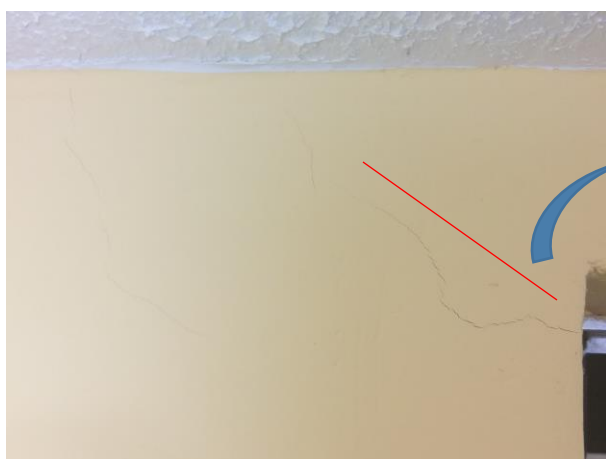
Figura 7 - Fissuras canto de janela (VISTA E)
