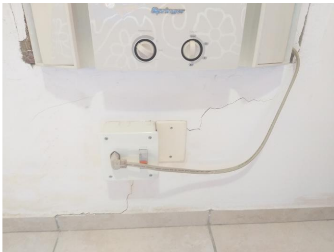
Figura 8 - Trincas oriundas de demolição (VISTA A)
