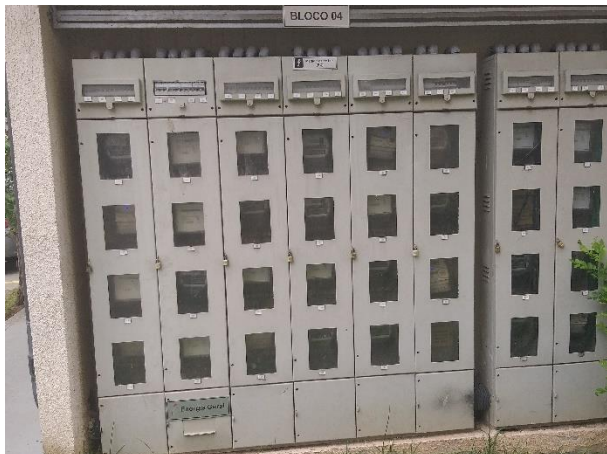
Figura 28 - Quadro Geral Bloco 4
