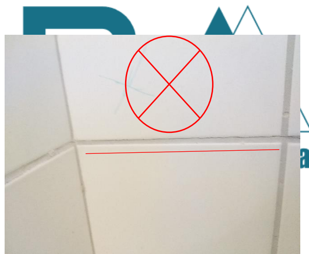
Figura 17 - Revestimento com som cavo (OCO) - (Vista C)
