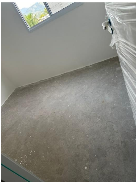
Figura 7 - Qt01 - Piso existente
