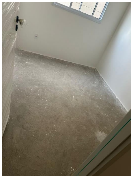
Figura 8 - Qt02 - Piso existente
